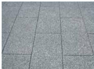
涼畳は、ショットブラストと目地切断により御影石調・石畳風の路面を呈した、夏季の路面温度上昇を抑える保水性舗装です。輻射熱が減少し、体感温度が低下するとともに、路面の色合いや造詣が目優しい感触を与えます。
