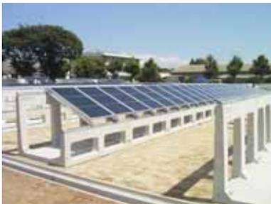
**コンクリートで架台をつくることにより、工期短縮やメンテナンス費の削減が図れます。**
