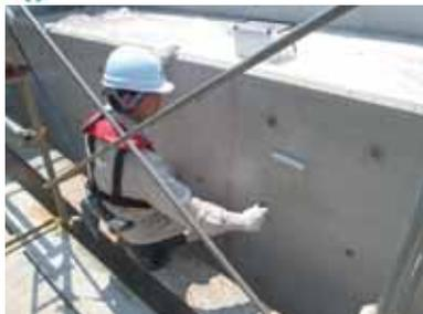
「T&C防食－塩害用－」は鉄筋コンクリート構造物の塩害に対する耐久性向上を主目的に開発された表面含浸工法です。一般的な表面含浸工法は撥水性を付与するシラン系、緻密化を図る珪酸塩系、いずれかの性能しか持ちませんが、本技術は珪酸塩系、シラン系双方の特徴を併せ持つハイブリッドタイプであり、遮塩性の飛躍的向上、海洋環境における施工性の他、高い安全性能を持つ工法です。
