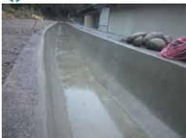
既存コンクリートに無機反応型改質材を含浸させ、表層を強化し、次に付着性の高い薄付仕上げモルタルで表面の不陸調整を行うことで、水路断面積を減らさずに粗度係数を回復します。更に前述の無機質反応型改質材とシリコンを主成分とした撥水材を上塗りする塗布型補修工法です。現場状況によっては、断面修復材の変更もでき、2軸、3軸ビニロンメッシュ・ガラス繊維シート敷設補強も可能です。
