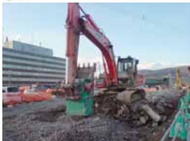
バックホウ (山積0.8m<sup>3</sup>) アタッチメント式機械による再生クラッシャーラン製造工 {コンクリート塊 (有筋、無筋)、岩石}
